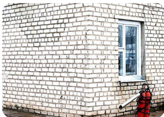
اجرای دیوار با آجر ماسه آهکی
