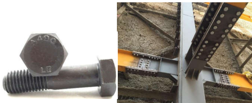
استفاده از پیچ‌های پر مقاومت A490 در اتصالات سازه فولادی
