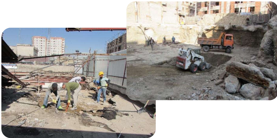
تخریب، گودبرداری و تسطیح محوطه
