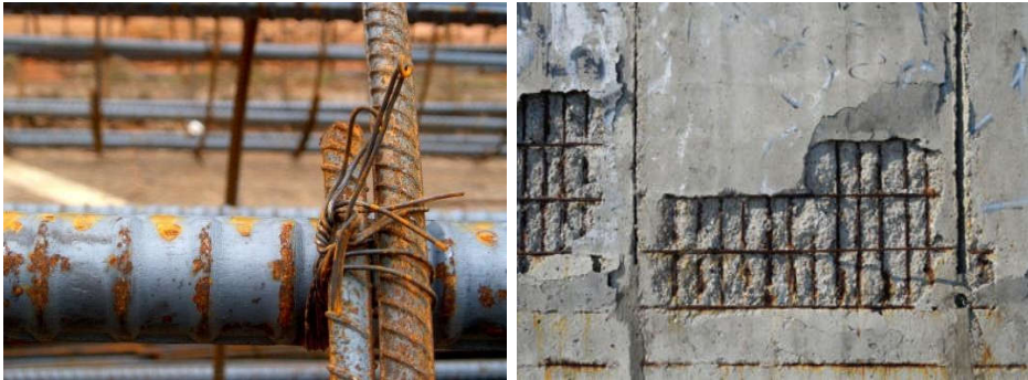
نمونه‌ای از خوردگی و زنگ زدگی میلگرد فولادی
