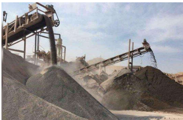
انبار و جداسازی مصالح سنگی از یکدیگر
