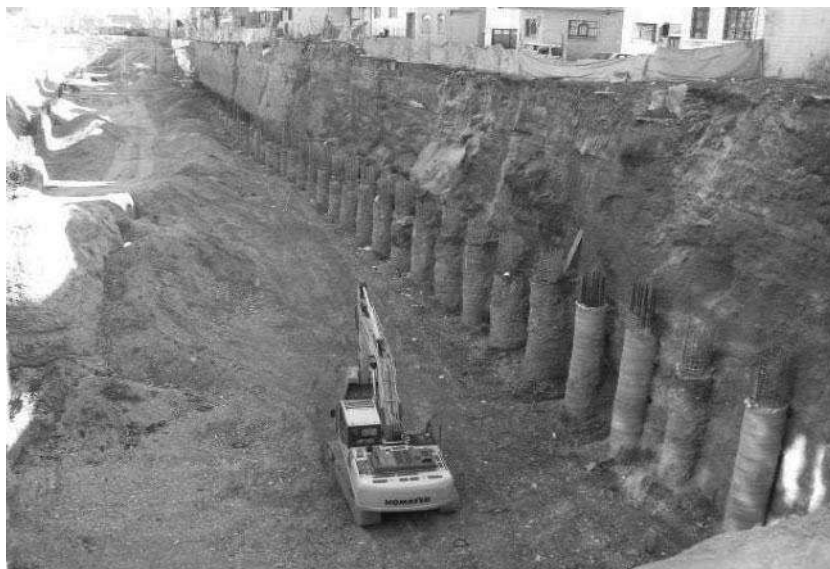
اجرای سازه نگهدار بصورت شمع و مایکروپایل
