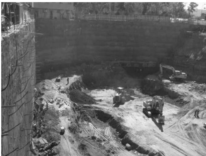
شکل ۳-۵ اجرای سازه نگهدارنده به روش جداره‌های مهاربندی شده دوخت به پشت
