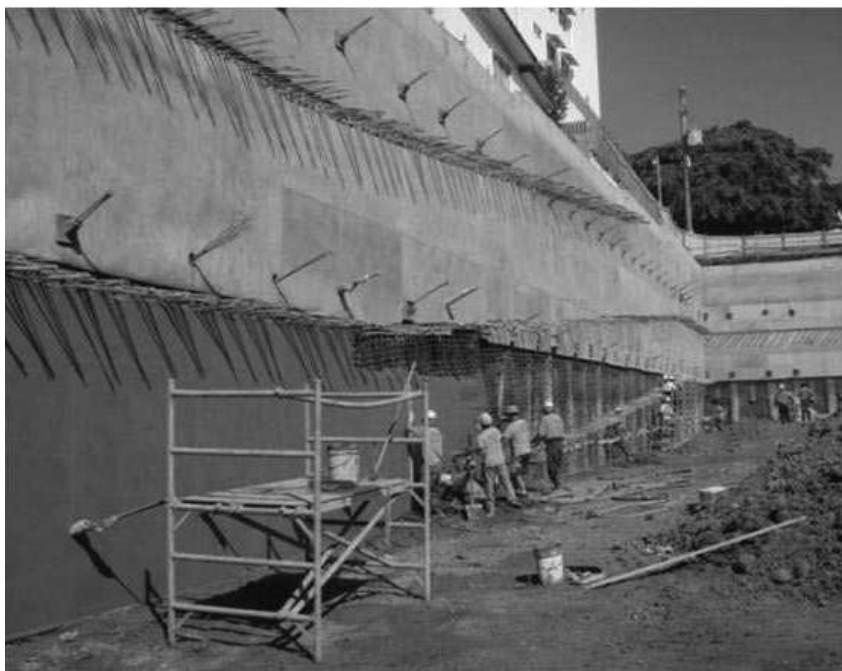
اجرای سازه نگهدارنده بصورت نیلینگ و انکراژ
