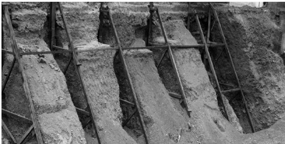
نمونه‌ای از سازه نگهدارنده خرابایی اجرا شده
