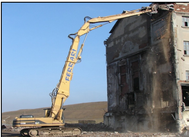
شکل ۴-۱ تخریب با فیچی هیدرولیک
