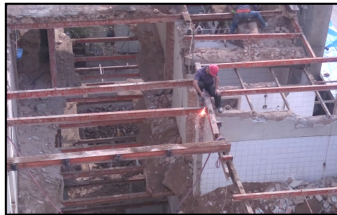
شکل ۹-۱ برش آهن‌آلات اسکلت با هوابرش
