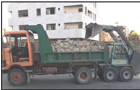
شکل ۱۰-۱ بارگیری و حمل نخاله‌ها به بیرون کارگاه
