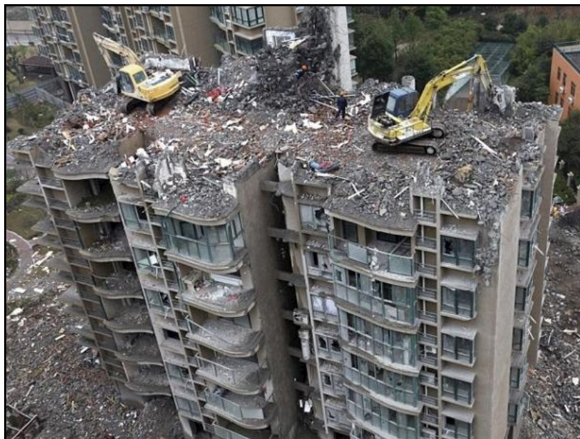
شکل ۱-۱ تخریب مکانیکی ساختمان مرتفع از بالا به پایین
