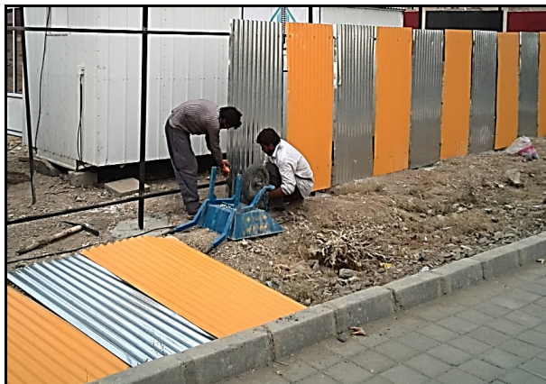
شکل ۱-۶ محصور کردن کارگاه قبل از تخریب
