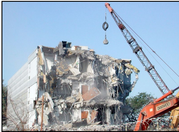
شکل ۱-۵ تخریب با استفاده از ضربه گوی فلزی
