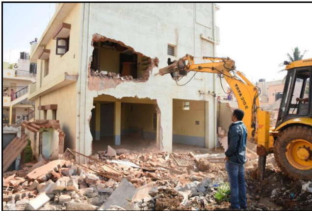
شکل ۳-۱ تخریب ساختمان با پیکور
