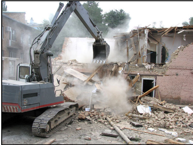
شکل ۲-۱ تخریب ماشینی توسط بیل مکانیکی
