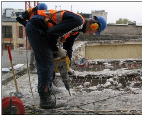
شکل ۷-۱ تخریب دستی سقفها از بالاترین نقطه ساختمان
