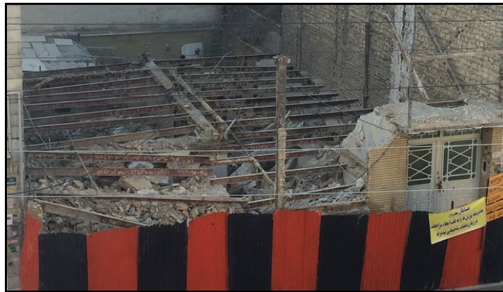
شکل ۸-۱ جمع‌آوری نخاله‌های ساختمانی و آماده‌سازی برای برش اسکلت
