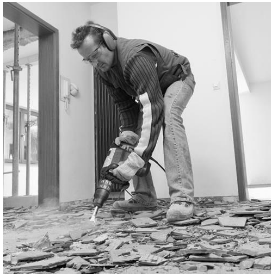
شکل ۱-۲) تخریب دستی با چکش هیلتی
