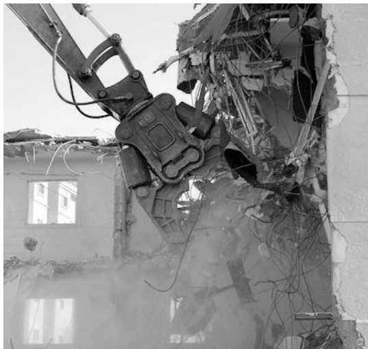
شکل (۱-۱) قیچی هیدرولیکی چرخشی
